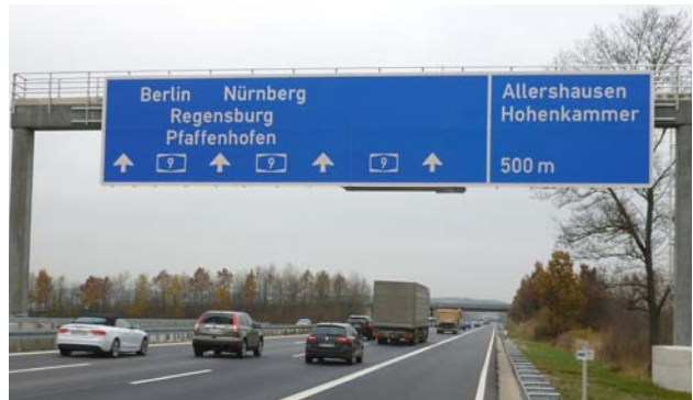
Wechselwegweisung ohne/mit Seitenstreifenfreigabe
