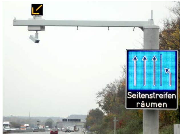
Kragarm mit Dauerlichtzeichen, Videokamera und Anzeige Z 223.3 StVO
