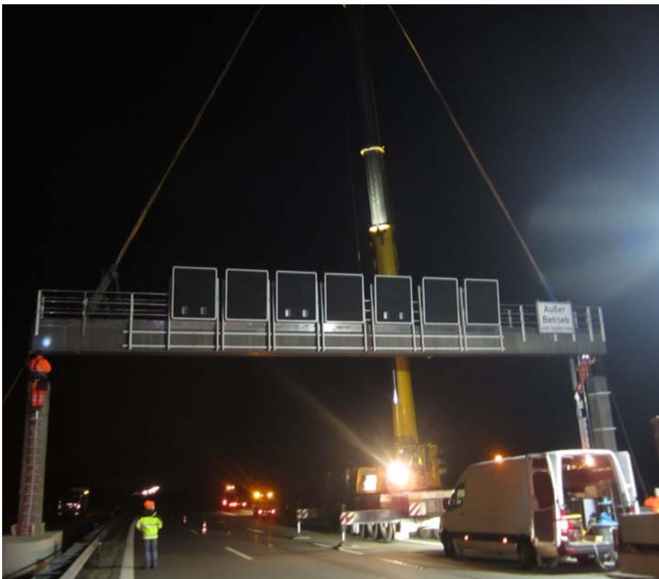
Montage einer Schilderbrücke aus Schleuderbeton in der Nacht
