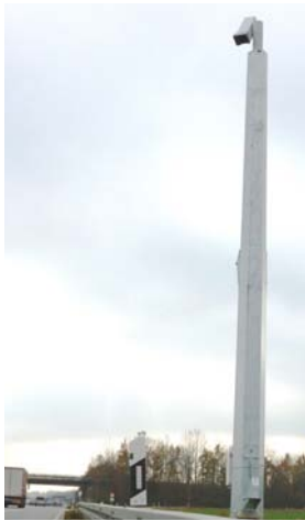
Videomast mit Kamera in Schwenk-Neige-Technik
