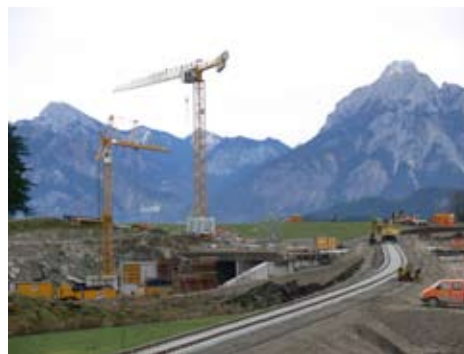
Tunnel Reinertshof - Bahnverlegung
