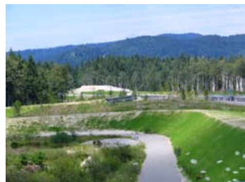
AS Füssen - Regenrückhaltebecken
