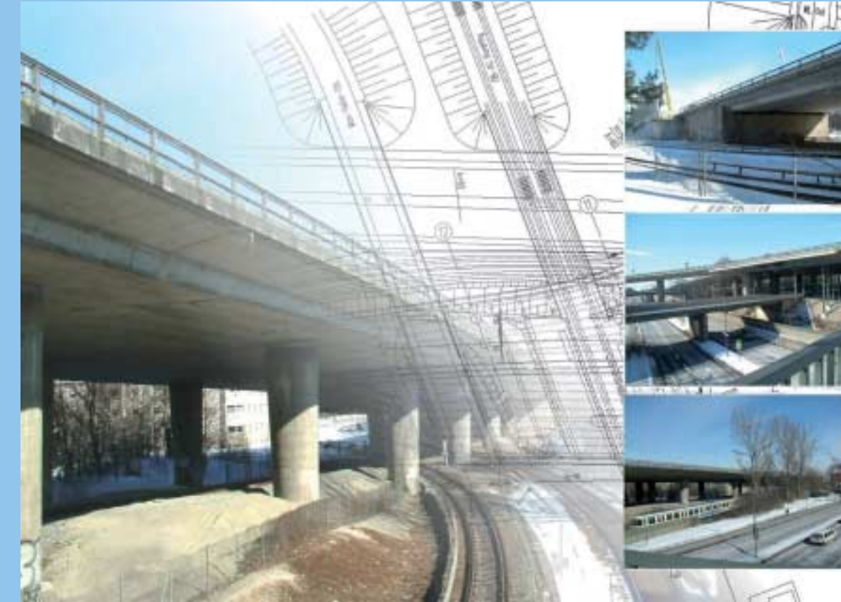
Bundesautobahn A 9 Rück- und Neubau der Hochbrücke Freimann
