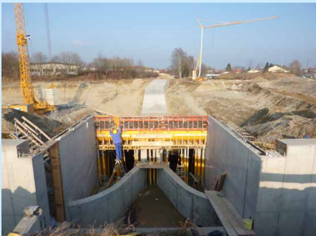
Bau eines Dükerbauwerks für den Howaschen
