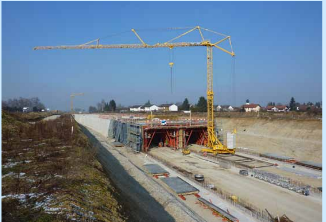
Bau der Einhausung Wimpasing
