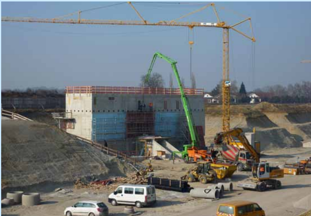
Betriebsgebäude der Einhausung
