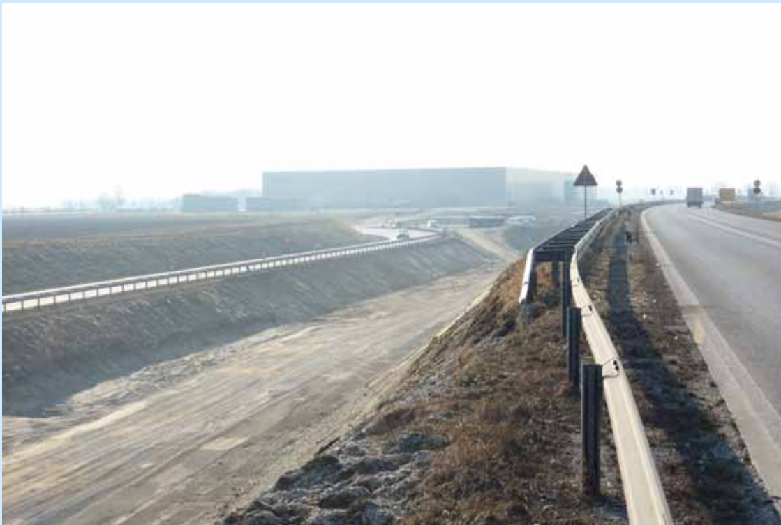
Anschluss an die A 94 am östlichen Bauende
